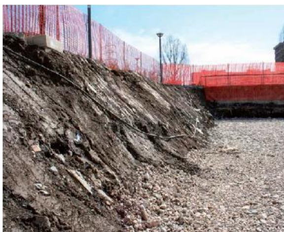
Profilo di scavo a stabilità naturale
