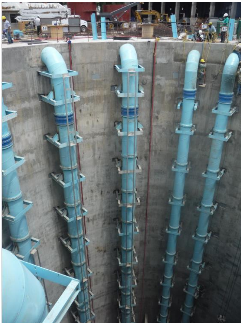
Figura 35 – Esempi di installazione di opere elettromeccaniche in pozzo profondo di pompaggio
