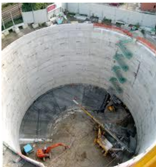
Figura 33 – Esempi di costruzione di pozzo profondo e scala di accesso
