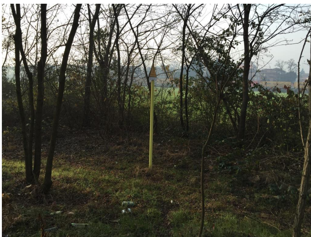
Figura 8 – palina di segnalazione linea interrata condotta SNAM
