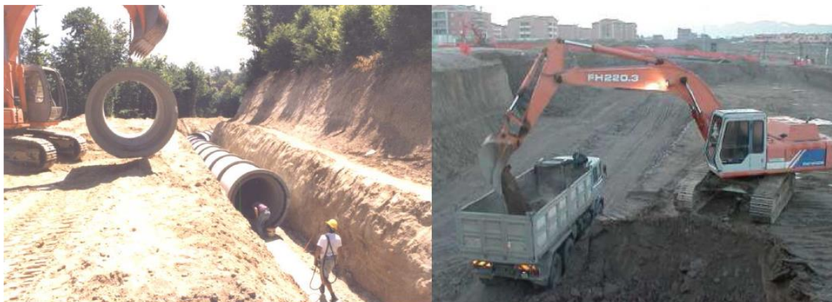
Operazioni di scavo di sbancamento ed a sezione obbligata (Fonte: CTP Roma)
